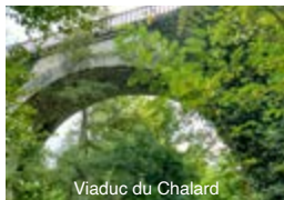
Viaduc du Chalard
