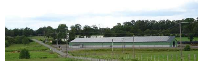
Bâtiment agricole récent
