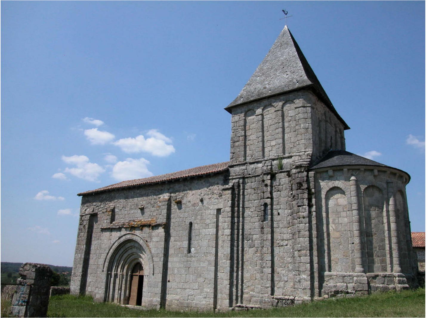
Eglise de Reilhac©Poa plume
