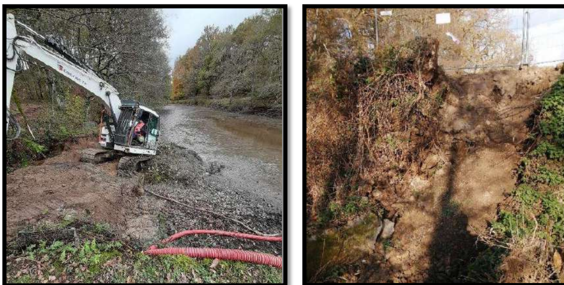
Figure 52 Pelle embourbée en rive droite à l'amont de la digue de Maziéras (Gauche) / Vue aval de la digue après nettoyage de la végétation (Droite)
